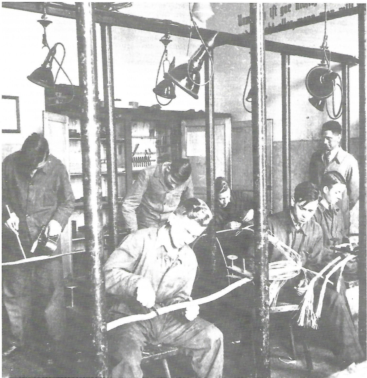
Es waren die traditionellen Ausbildungsabschnitte, in denen die ersten Praktikanten ausgebildet wurden: Metallbearbeitung, Holzbearbeitung, Apparate-technik, Stromversorgung, Sprechstellenbau, ober- und unterirdischer Linienbau und Kabelmontage. Das Bild zeigt Praktikanten des Einstellungsjahrgangs 1940 in der Lötwerkstatt bei der Kabelmontage. Die Kabelstücke waren an senkrechten Eisenrohren festgeklemmt, dazwischen konnten die Adern miteinander verbunden und durch Bleimuffen verschlossen werden. Im Vordergrund Karlheinz Feja. Rechts stehend der Ausbilder Josef Völlmeke.
